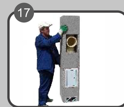
16 Limena vrata montirati na priključak za vrata.
