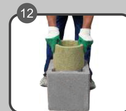
11 Tervol ploče staviti u plašt.
