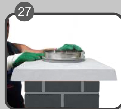
Sa inox prstena odlijepiti zaštitnu traku i isti postaviti u završnu ploču.
