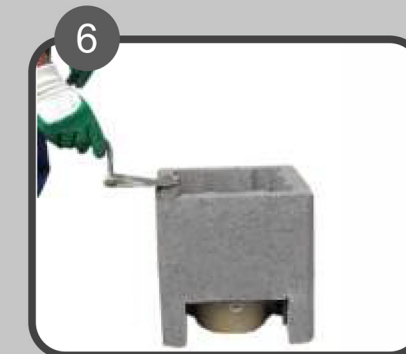
6 Kod nastavka zidanja na plašt nanijeti mort, a na rubove kondenzacijske posude kit za spajanje.
