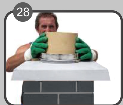
Izmjeriti potrebnu visinu zadnje cijevi do visine konusnog završetka, istu odrezati i ugraditi je kroz prsten završne ploče.
