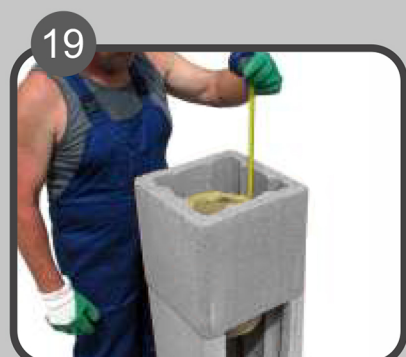
19 Zadnju cijev odrezati 3 cm niže od razine zadnjeg plašta.
