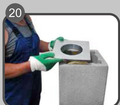
20 Montirati diletacijsku rozetu.
