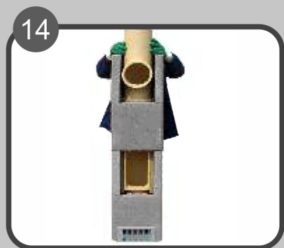
14 Na isti način montirati priključak za peč.
