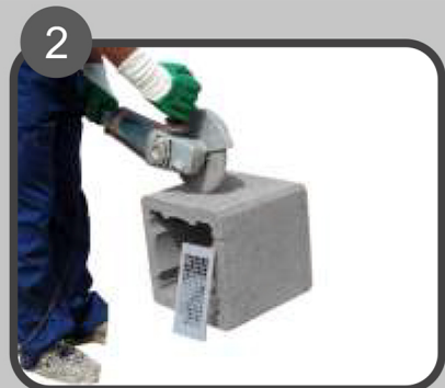
1 Dimnjak se počinje zidati na pripremljenu podlogu visine gotovog poda. Na prvom plaštu izrezati otvor za ventilacijsku rešetku.
