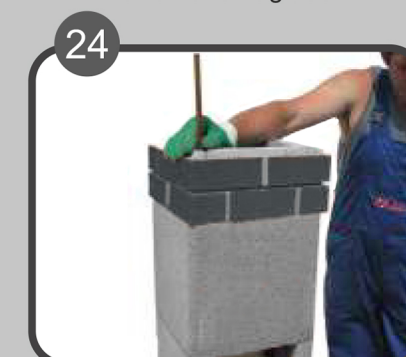
24 Nakon potrebne visine završne elemente armirati.
