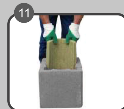
11 Tervol ploče staviti u plašt.
