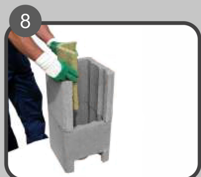
8 Plašt staviti na naneseeni mort, te postaviti izolaciju.
