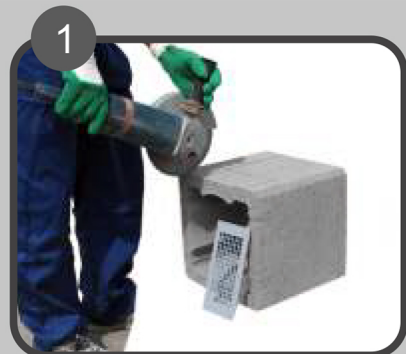
1 Dimnjak se počinje zidati na pripremljenu podlogu visine gotovog poda. Na prvom plaštu izrezati otvor za ventilacijsku rešetku.
